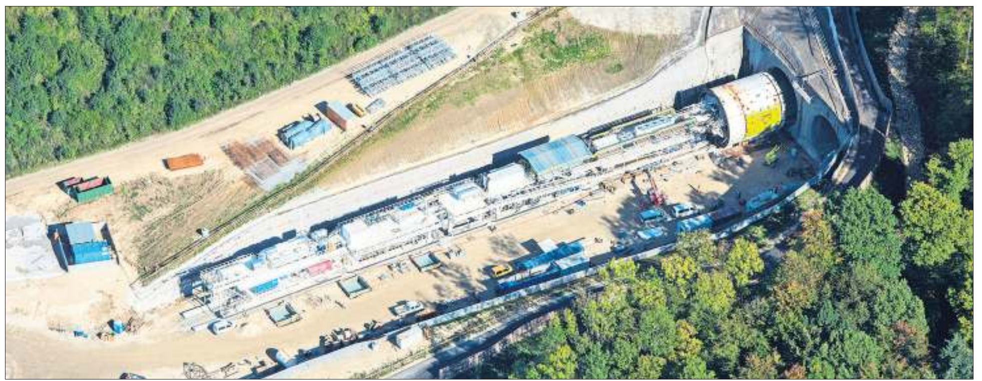
Die 110 Meter lange Bohrmaschine soll ein Stück des Boßlertunnels graben. Die Röhren sind Teil des Albaumstiegs bei der neuen Bahnstrecke von Wendlingen nach Ulm
